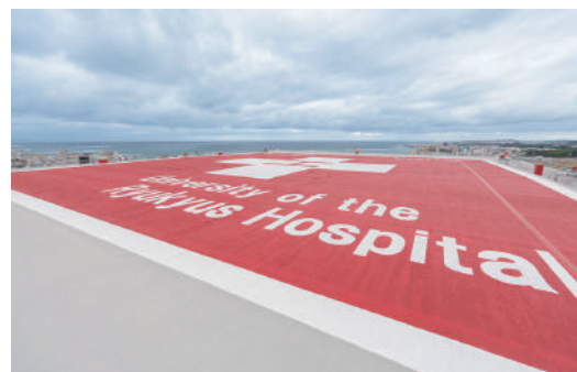
屋上のヘリポートはエレベーターを介して手術室に直結
