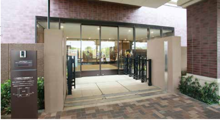
止水板を設け、幅を狭くしたエントランス。周囲には通常より高い免震擁壁を設置
